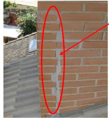
Fotografía 8. Mampostería fisurada en las esquinas del apoyo de la viga limatesa.
